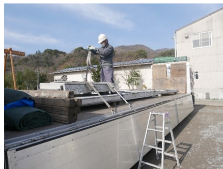
写真2 GRCの積み込み作業
