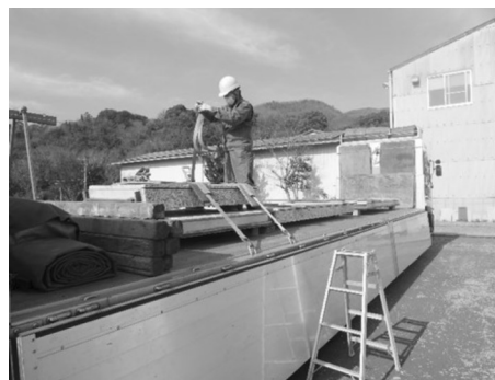
写真2 GRCの積み込み作業
