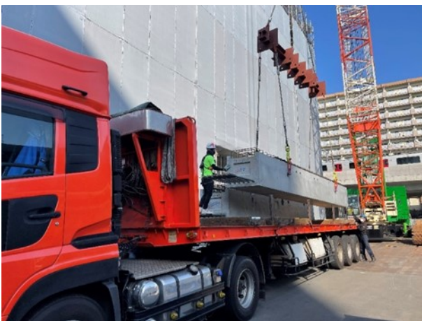
現場での荷卸し風景
