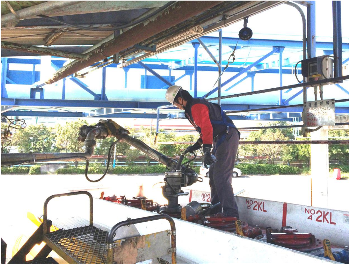
写真3 (ハーネス型安全帯着用、写真の左下はプラットフォームへの渡り階段(ローリングラダー)、運転手の背中は落下防止柵、写真左からの積み込み配管はローリーに密閉接続されている)
